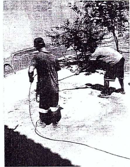
Moradores em situação de rua preparando a massa para reforma de uma parede
